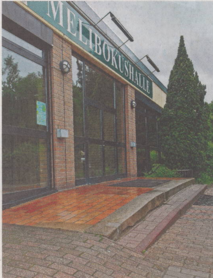
Über eine lange Rampe ist das Foyer der Zwingenberger Melibokushalle barrierefrei zu erreichen. FOTO: LUTZ IGIEL
